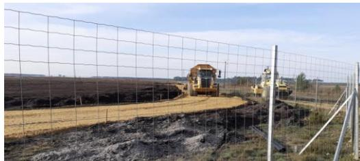
Figure 27 - Réalisation de clôture et pistes d'une centrale solaire
