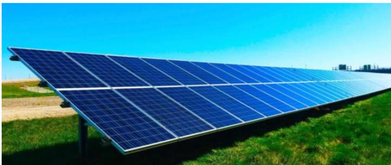
Figure 24 - Exemple de rangée de tables fixes 2V13 portrait d'une centrale photovoltaïque au sol
