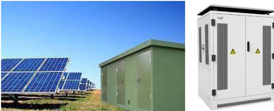
Figure 33 - HTA photovoltaïque et Shelter basse tension
